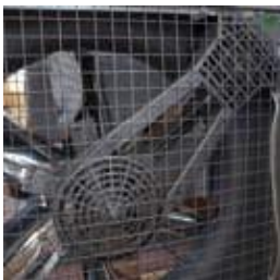
Moyeu en aluminium et pales en Inox
